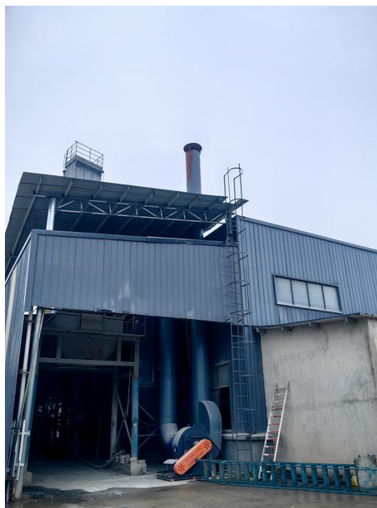
水稳料投料粉尘、搅拌粉尘 (布袋除尘)
