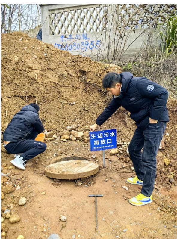
生活污水排放口
