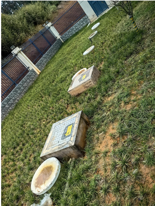
污水站臭气加盖
