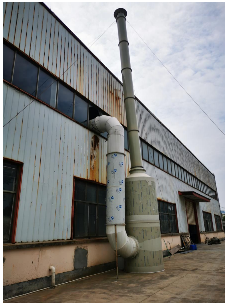
脱脂、钝化废气处理设施（一级碱喷淋）
