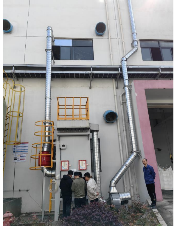
胶料投料粉尘废气处理设施（布袋除尘器）（DA008）
