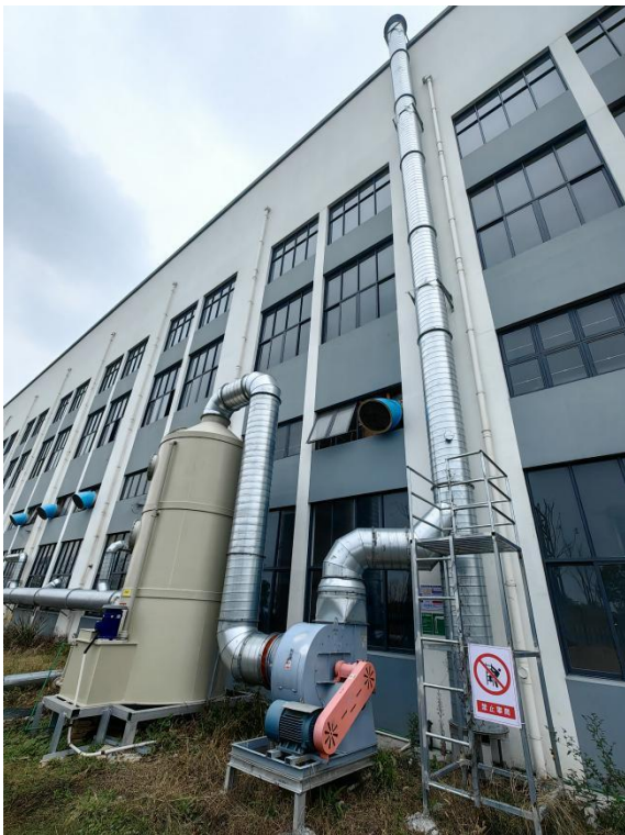
印刷废气处理设施（水喷淋）（DA005）
