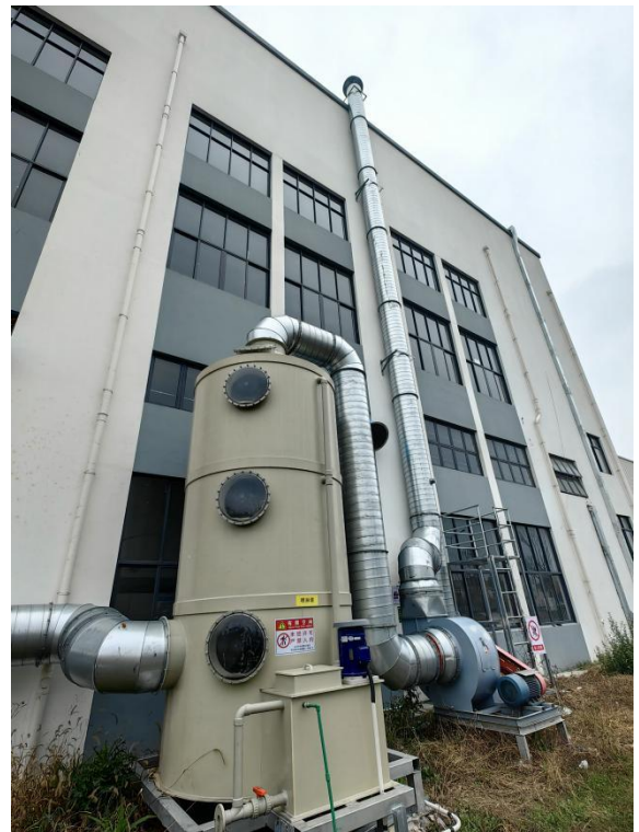
印刷废气处理设施（水喷淋）（DA005）
