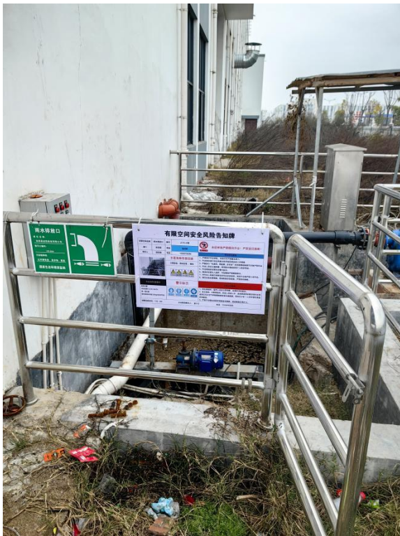
本项目雨水排放口
