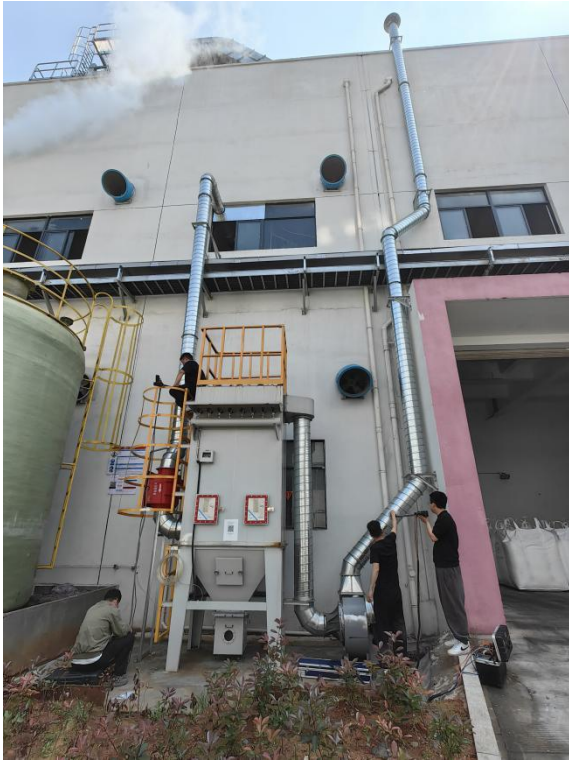
胶料投料粉尘废气处理设施（布袋除尘器）（DA008）
