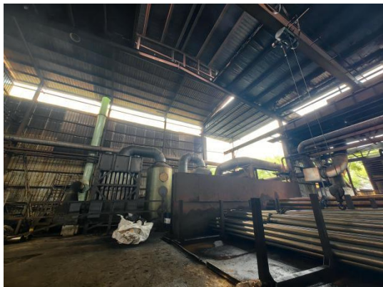
退火炉废气处理设施
